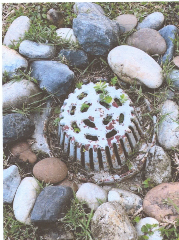
ภาพที่ 46 แสดงตะแกรงดักขยะภายในโครงการ
