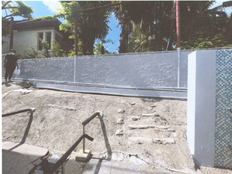
ภาพที่ 47 แสดงกำแพงป้องกันการพังทลายของหน้าดินภายในโครงการ
