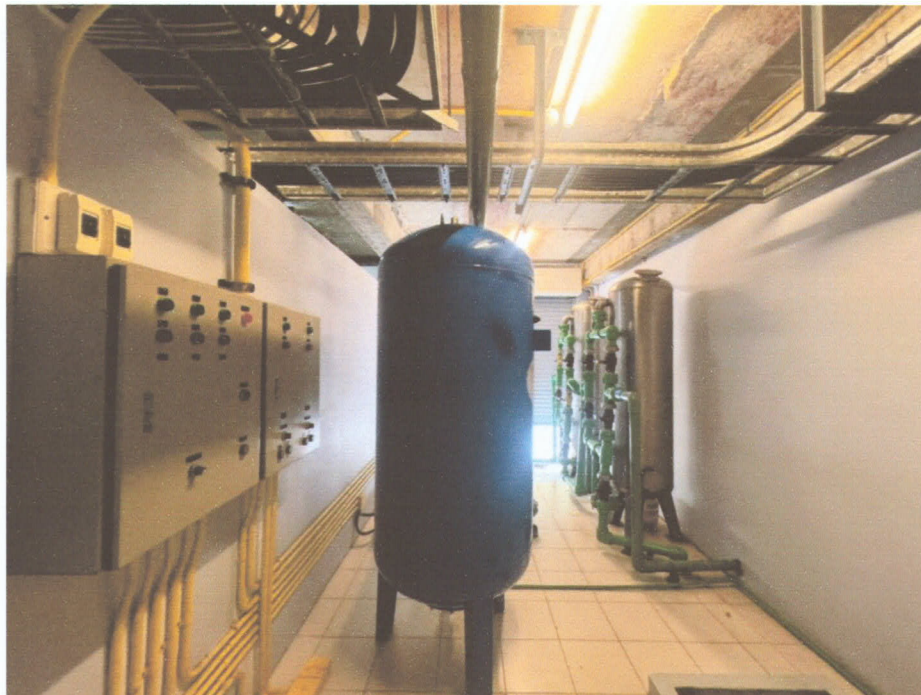
ภาพที่ 17 แสดงถังกรองผลิตน้ำใช้ภายในโครงการ
