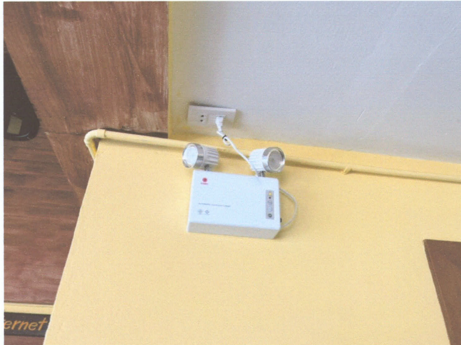
ภาพที่ 34 แสดงไฟส่องสว่างฉุกเฉินภายในโครงการ
