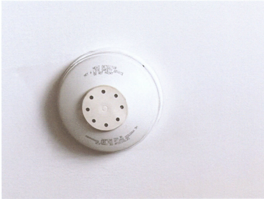
ภาพที่ 35 แสดงเครื่องจับควันภายในโครงการ
